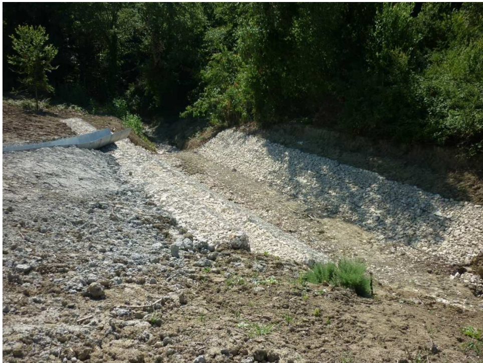
Fotografia 3-9: Particolare dello scarico delle acque di drenaggio al Rio Pavanella.
