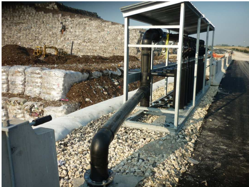
Fotografia 3-5: Particolare di una sottostazione di regolazione del biogas.
